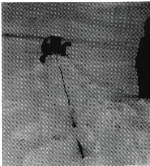
900m kabel blir kjørt ut med traktor.
